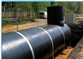
Fasce in acciaio inox per contrastare le spinte di galleggiamento
